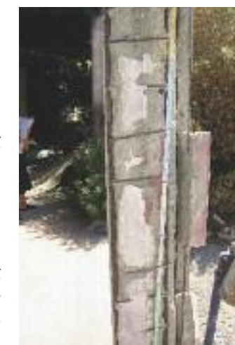
φωτ. 5. κτίριο Β2: λεπτομέρεια υποστυλώματος φωτ. 4
