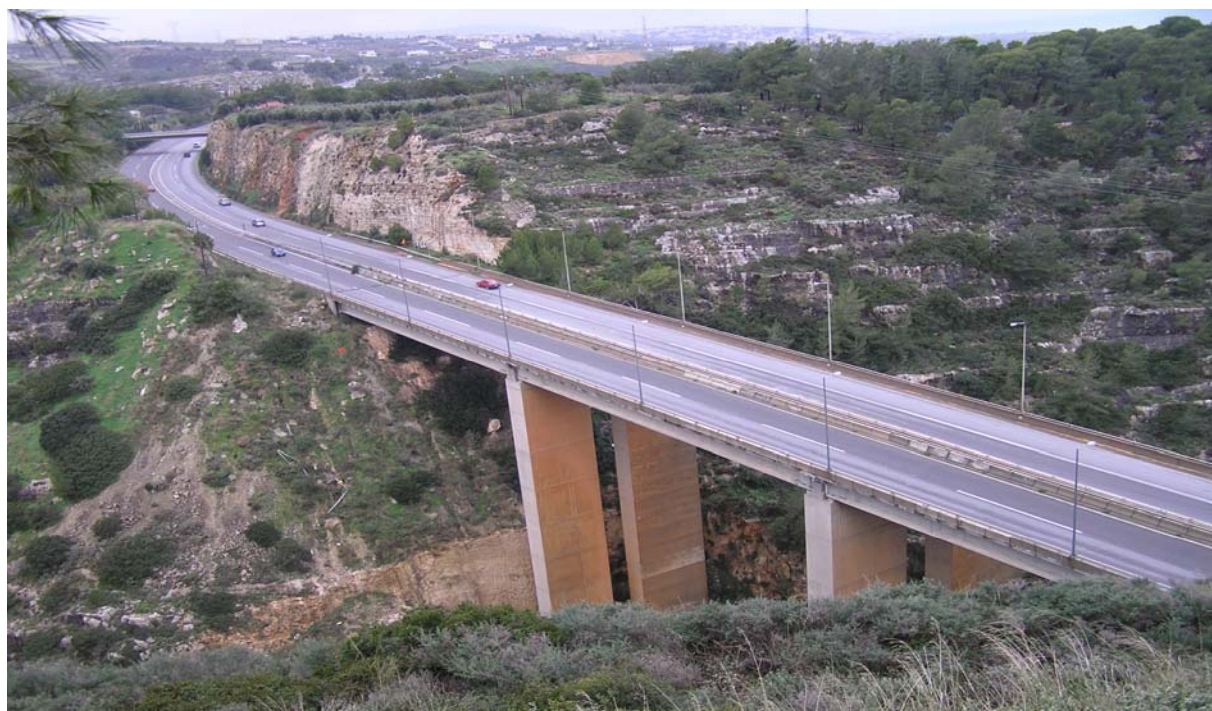
Δυτική Γέφυρα Παράκαμψης Ρεθύμνου
