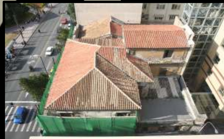
ΠΕΙΡΑΙΩΣ BUILDINGS -Μελέτη Αποκατάστασης & προσθήκη καθ' ύψος γραφείων & υπογείου χώρου στάθμευσης, στα διατηρητέα κτίρια του Σπηλιοσπουλείου Ιδρύματος, επί των οδών Σταδίου 6 -8 & Αμερικής
