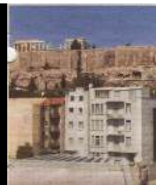
Στην επκαιρότητα η κατασκευή των κτιρίων της Δ. Αρσολαγίτου.
