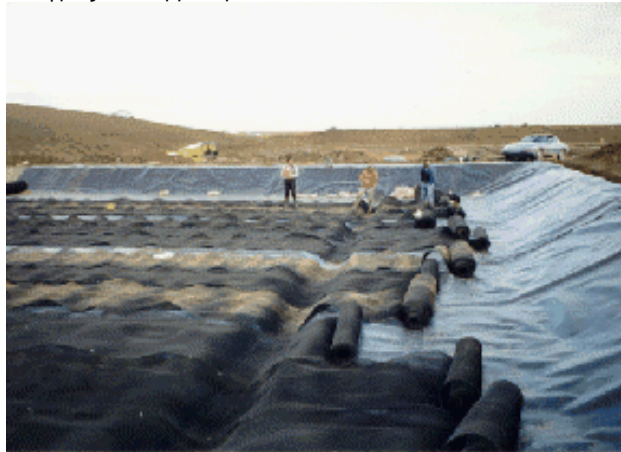
Εικόνα 23. Διπλή επένδυση βιοαντιδραστήρα (MSW, 2005).
