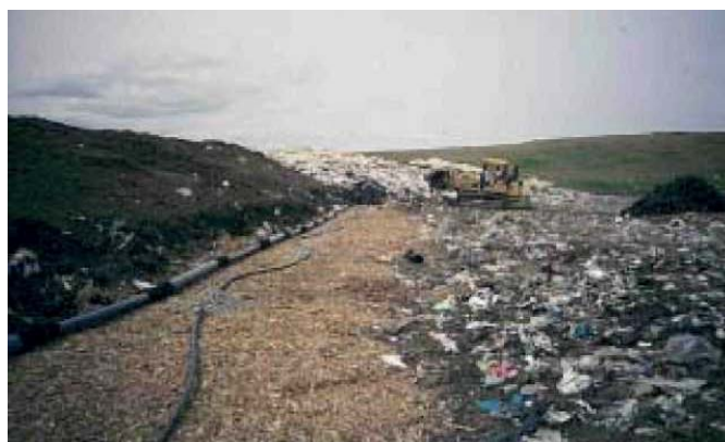
Εικόνα 5. Εγκατεστημένο οριζόντιο δίκτυο συλλογής βιοαερίου και υγρών διασταλαγμάτων με ελαστική επίστρωση (Yazdani et al. , 2005).
