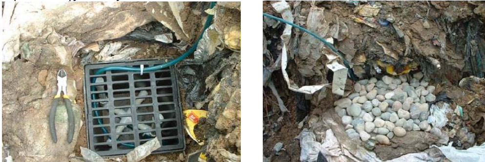
Εικόνα 4. Σύστημα δειγματοληψίας στραγγισμάτων πριν και μετά την επικάλυψη με χαλίκι (Zhao et al. , 2003).
