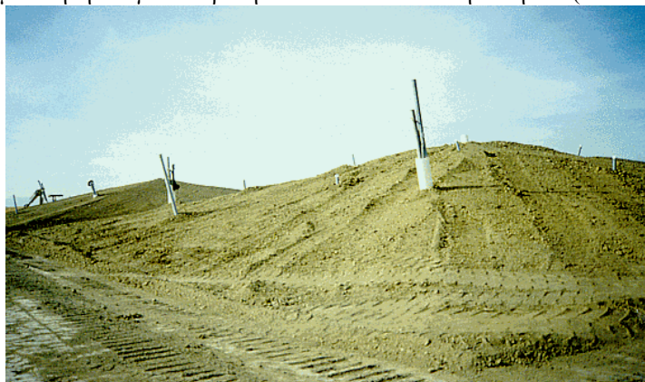
Εικόνα 26. Τοποθέτηση γεωφίλτρου και κάλυψη με χώμα (MSW, 2005).
