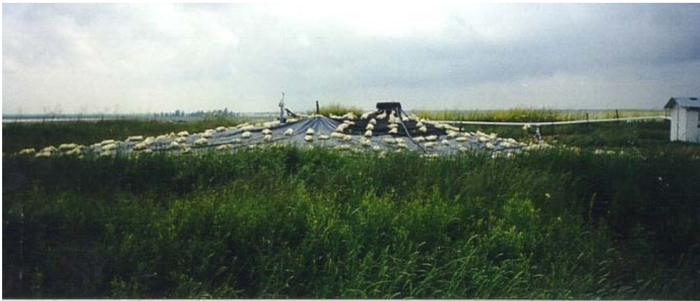
Εικόνα 28. Επιφανειακή κάλυψη βιοαντιδραστήρα (MSW, 2005).
