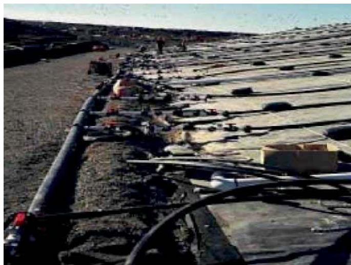
Εικόνα 10. Κύριο και πλευρικό δίκτυο σωληνώσεων στραγγισμάτων (Yazdani et al. , 2005).
