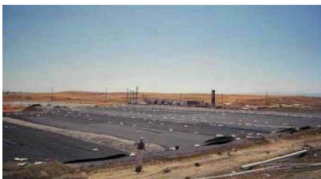
Εικόνα 17. Αερόβιο τμήμα έτοιμο για την τοποθέτηση στρώματος τεμαχισμένων ελαστικών αυτοκινήτων και την τοποθέτηση απορριμμάτων (Yazdani et al. , 2005).
