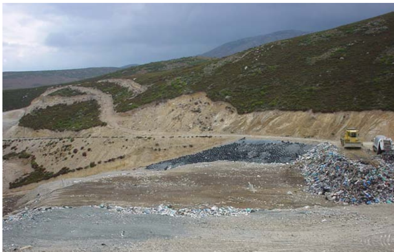
Εικόνα 1. Διάθεση με ψεκασμό (ΧΥΤΑ Αμαρίου).
