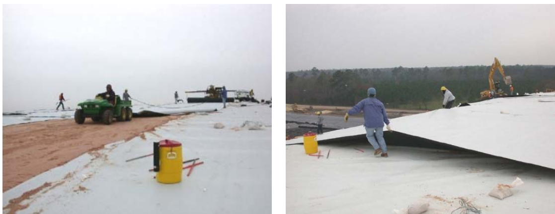
Εικόνα 36. Τοποθέτηση γεωμεμβράνης ενισχυμένου πολυπροπυλενίου (NSWMA, 2005).
