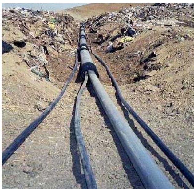
Εικόνα 20. Οριζόντιο δίκτυο συλλογής αέρα (Yazdani et al. , 2005).
