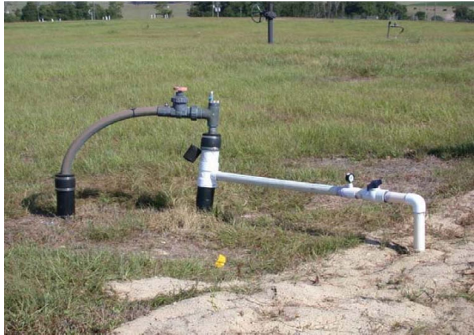
Εικόνα 21. Επανακυκλοφορία στραγγισμάτων (Yazdani et al. , 2005).
