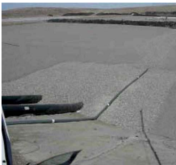
Εικόνα 11. Κάλυψη με αμμοχάλικο και φρεάτιο συγκέντρωσης υγρών (Yazdani et al. , 2005).
