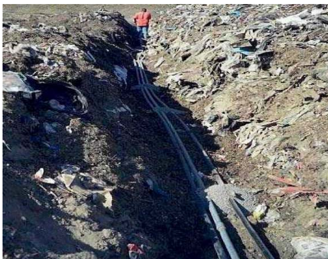
Εικόνα 19. Πλευρικό δίκτυο συλλογής στραγγισμάτων στην τάφρο (Yazdani et al. , 2005).
