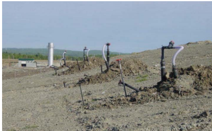
Εικόνα 33. Επανακυκλοφορία στραγγισμάτων (Pollution Probe, 2005).
