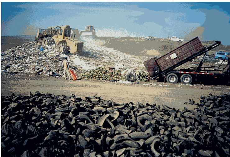
Εικόνα 25. Τοποθέτηση τελικού στρώματος αποβλήτων (MSW, 2005).
