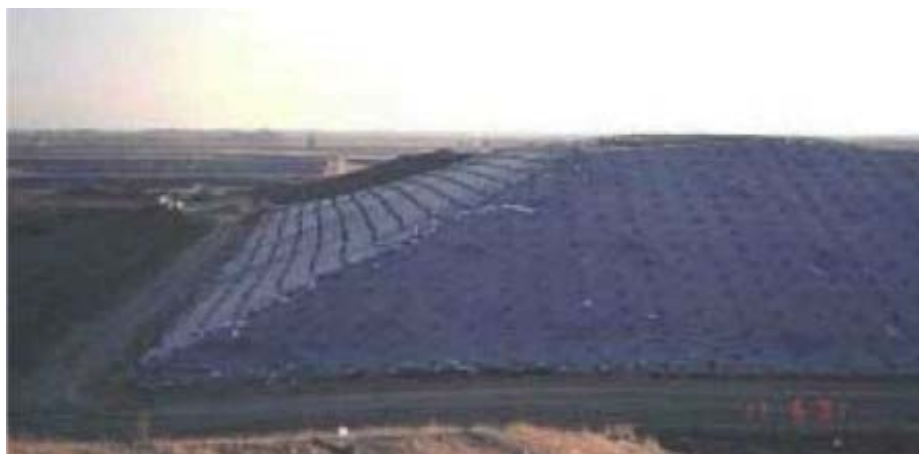
Εικόνα 7. Κάλυψη του βορειοανατολικού αναερόβιου τμήματος του βιοαντιδραστήρα (Yazdani et al. , 2005).
